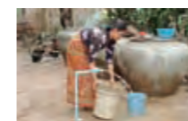
EL AGUA POTABLE SUMINISTRADA POR EL POZO LLEGA A LAS VIVIENDAS MEDIANTE UN SISTEMA DE TUBERÍAS INSTALADAS DURANTE EL PROYECTO. GLOBAL HUMANITARIA/OUR HOME (FOTO)
