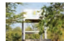
EL POZO Y EL DEPÓSITO FUNCIONAN DESDE EL AÑO 2004, CUBRIENDO UNA DE LAS NECESIDADES BÁSICAS DE LA ZONA. GLOBAL HUMANITARIA/OUR HOME (FOTO)
